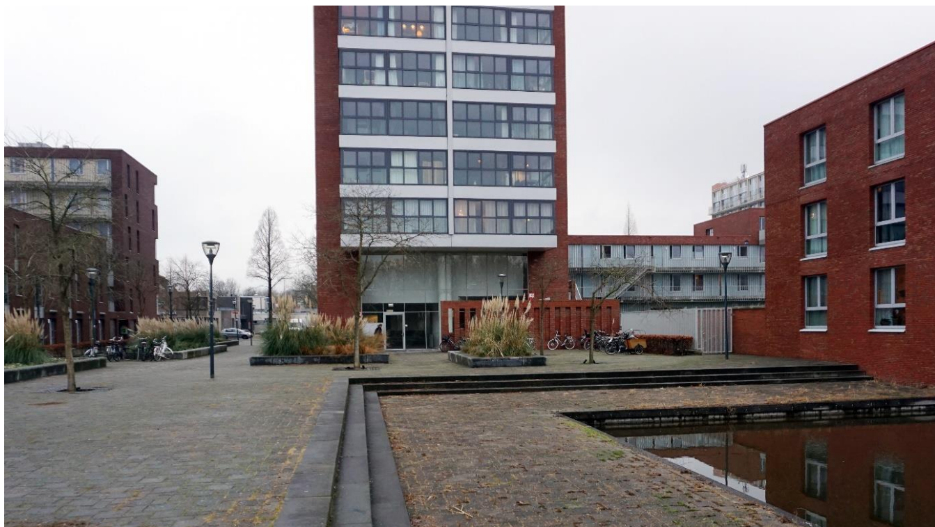
Huidige situatie - achterzijde
