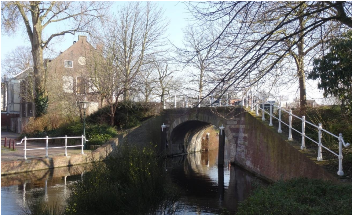
De Vlietbrug met poppenleuningen in 2017. Poppenleuningen staan van oudsher ook op kades, daar waar een straat of steeg uitkomt op het water.
